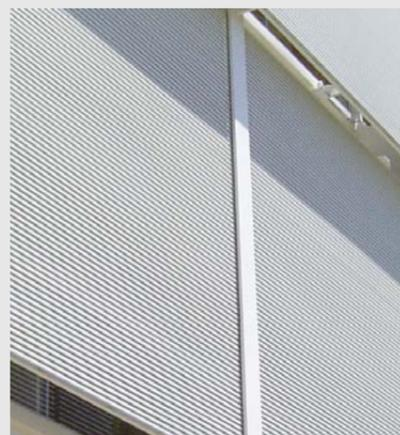
Quebravista formado por paneles en forma de U en aluzinc termoesmaltado, con separación variable según requerimientos del proyecto. Es un elemento arquitectónico que usa paneles lineales de modulación de ancho pequeño, especial para soluciones de tipo celosía, vanos de fachadas, logias, cajas de escaleras, cielos y aleros. Debido a su bajo peso, este producto es ideal para renovaciones de fachadas.
